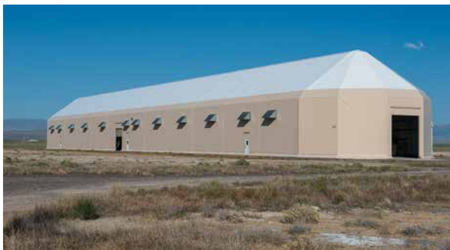
Active Standoff Chamber – widok z zewnątrz
