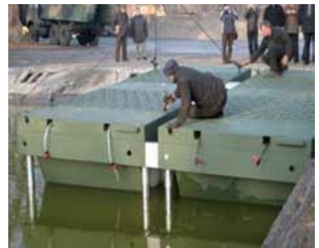
Łączenie dwóch modułów mostu kasetowego
