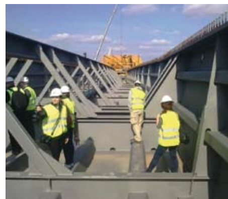
Kwiecień 2011. Studenci specjalności budowa dróg i mostów na budowie Mostu Północnego. U góry: podnoszenie przęsła środkowego, u dołu: „inspekcja” wnętrza konstrukcji
