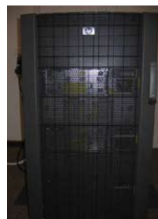
UPS 17 KV zasilający centrum komputerowe
