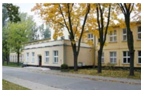
Budynek Instytutu Telekomunikacji
