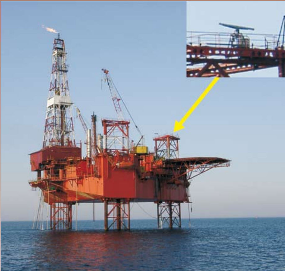
Zdj. 4. Platforma wiertnicza, na której zainstalowano radar obserwacji skażeń ropopochodnych
