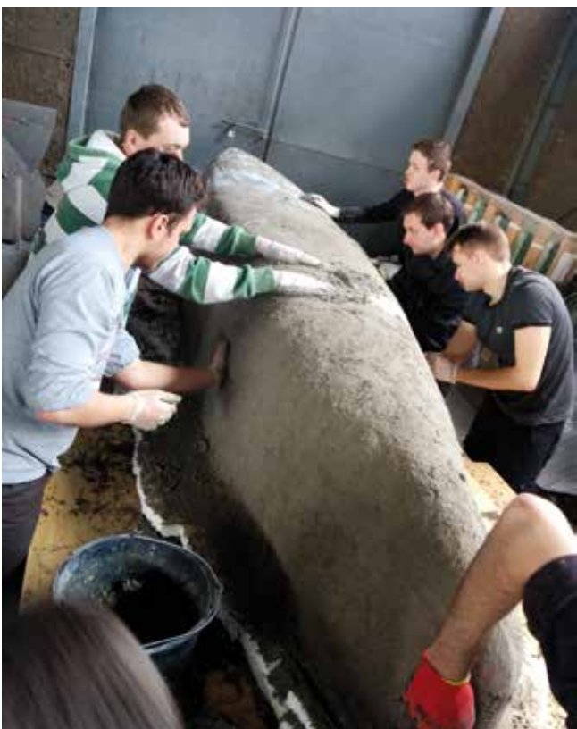
Budowa kajaka z betonu
