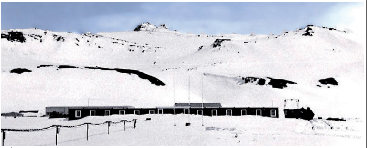
Marzec 1977 r. Budynek główny stacji
