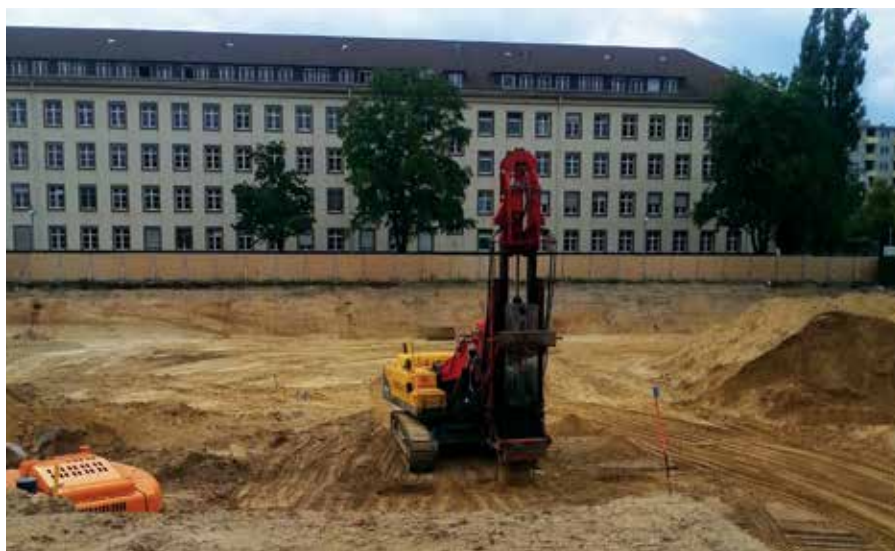
Maszyna do zagęszczania impulsowego w Berlinie
