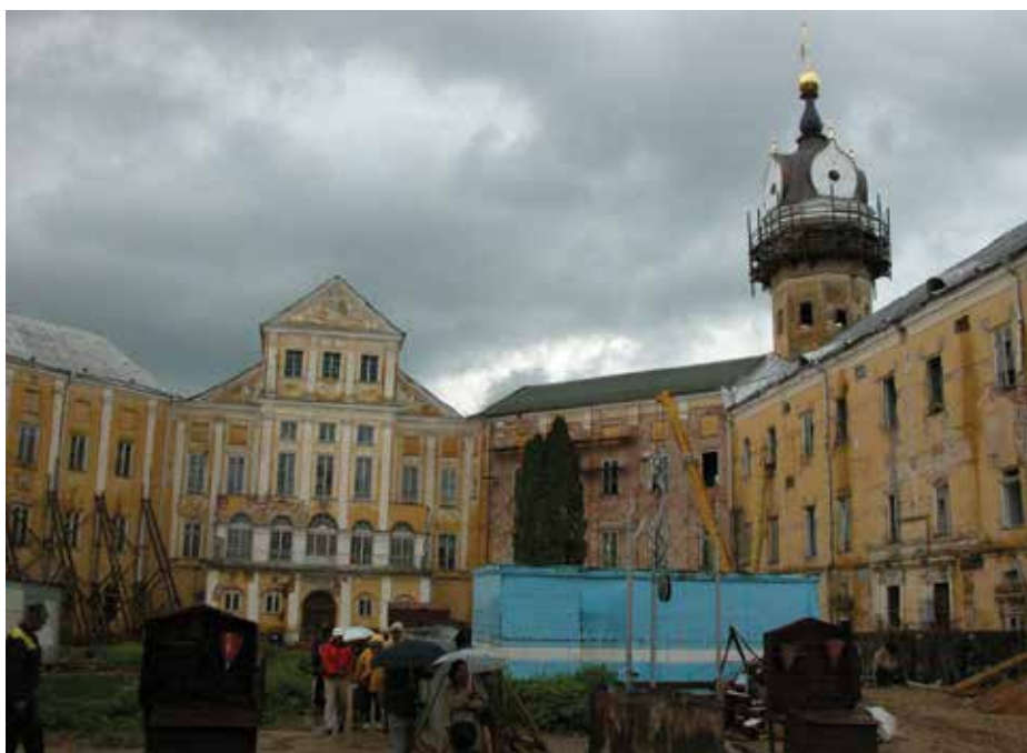
Zamek w Nieświeżu w trakcie konserwacji
