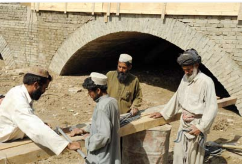
Infrastruktura Afganistanu mocno ucierpiała po ponad trzydziestu latach trwania wojen i konfliktów wewnętrznych. Krajowi potrzeba mostów i przepraw, szpitali i nowych placówek zdrowia
