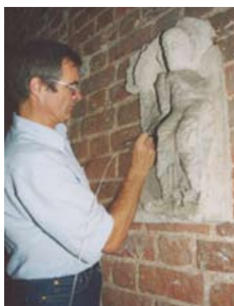
Rzeźba Pantokratora Tronującego w trakcie czyszczenia laserowego. Archikolegiata w Tumie k. Łęczycy (na zdjęciu dr hab. inż. Jan Marczak, prof WAT)
