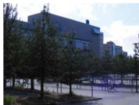
Budynek przy ulicy Yliopistokatu 18
