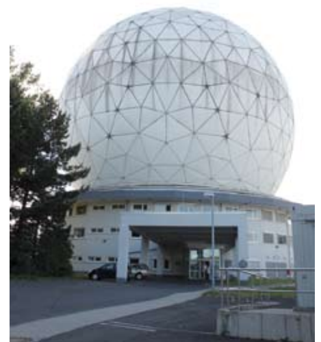
Kopuła radaru TIRA – z daleka rozpoznawalny znak instytutu Fraunhofer FHR
